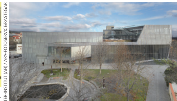
Kultur Kongress Zentrum Eisenstadt: Überzeugend sowohl städtebaulich als auch in seiner Verschränkung von Bestand und Neubau. Der das Gebäude umhüllende Metallscreen schafft eine Einheit.
